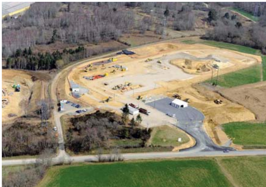
VUE AÉRIENNE DU CHANTIER UKAD À SAINT-GEORGES DE MONS (FRANCE).
