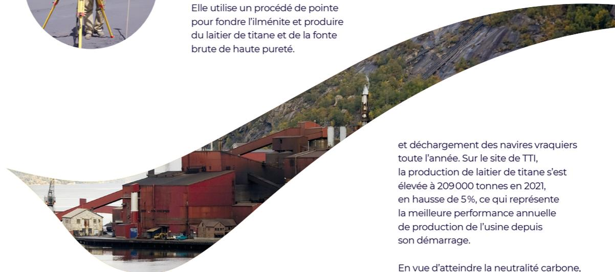
Ces produits sont vendus principalement aux producteurs de pigments et aux fonderies de fonte ductile. L'usine est la seule en Europe à utiliser ce procédé. Elle présente une capacité annuelle de 215 000 tonnes de laitier de dioxyde de titane et de 85 000 tonnes pour la fonte de haute pureté. Le site, qui emploie près de 300 personnes, bénéficie d'un accès privilégié à l'énergie hydroélectrique et d'un quai permettant le chargement
