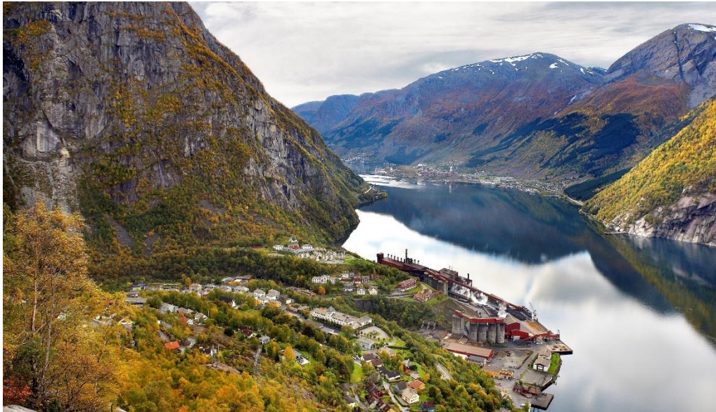
Tyssedal, Norvège : L'usine de conversion de TTI produit du laitier de dioxyde de titane et de la fonte de haute pureté à partir d'ilménite.
