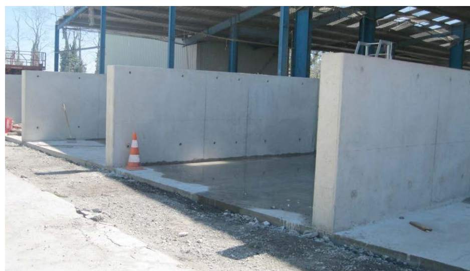
Alvéoles de la halle de stockage
