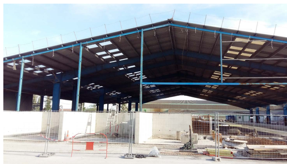
Halle de stockage 4 000 m 2
