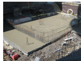
Avancement travaux FEL
