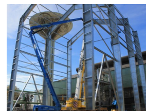
Travaux bâtiment FEL
